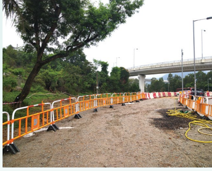
地盤清理 Site Clearance
