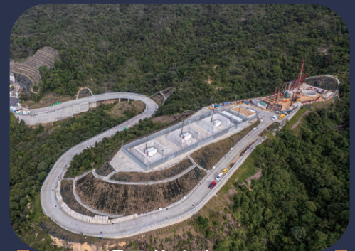
通風井建造工程 Construction of Ventilation Shaft
