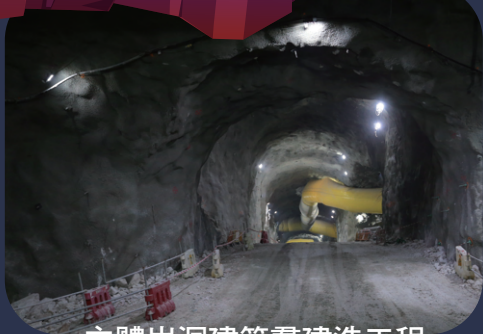
主體岩洞建築羣建造工程 Construction of Main Caverns Complex
