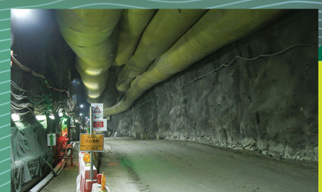
主體岩洞建築群建造工程 Construction of Main Caverns Complex
