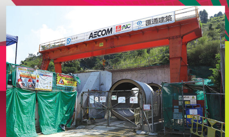
頂管工程 Pipe Jacking Works
