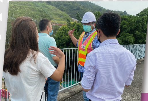
2020年9月4日與區議員觀察第一次爆破工程進行 Observed the first blasting works with District Council Members on 4 September 2020
