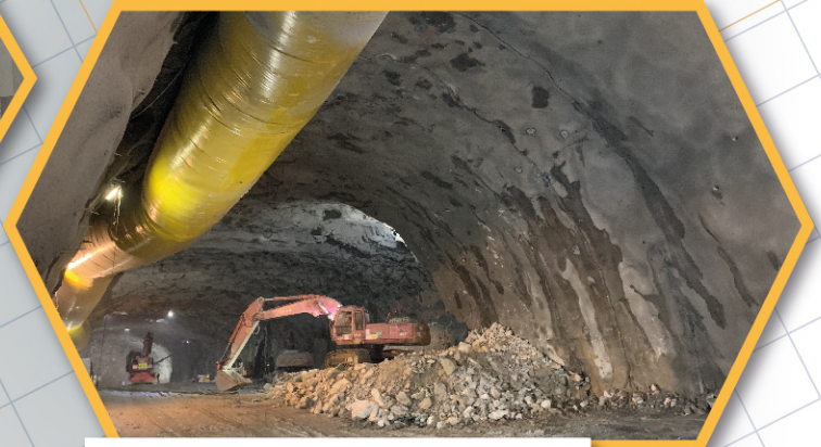
主連接隧道建造工程 Construction of Main Access Tunnel
