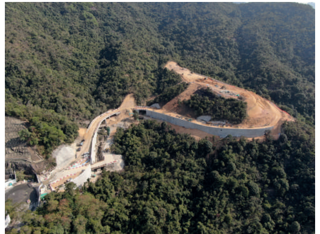
連接通風井道路建造工程 Construction of the Access Road to Ventilation Shaft
