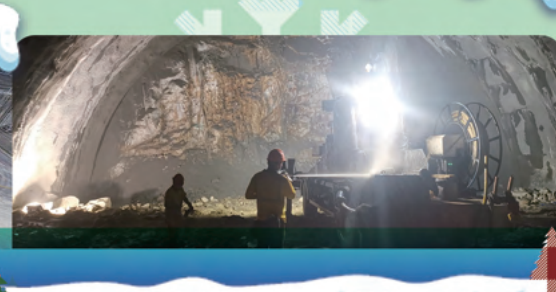
主連接隧道(西)建造工程 Construction of Main Access Tunnel (West)
