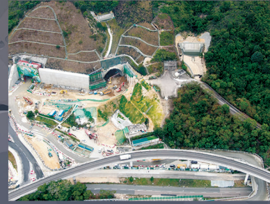
主連接隧道（西）建造工程 Construction of Main Access Tunnel (West)
